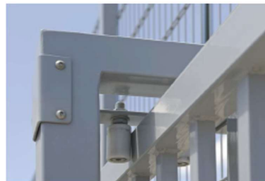
Pórtico de guia com roletes em nylon no topo do portão.
